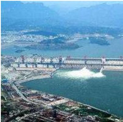
**三峽大壩：**2006 年 5 月，全長 2309 米的三峽大壩全線建成，全線澆築達到設計高程海拔 185 米，是世界上規模最大的混凝土重力壩。三峽工程是迄今世界上綜合效益最大的水利樞紐，在發揮巨大的防洪效益和航運效益外，其 1820 萬千瓦的裝機容量和 847 億千瓦時的年發電量均居世界第一，三峽大壩榮獲中國世界紀錄協會世界最大的水利樞紐工程世界紀錄。
